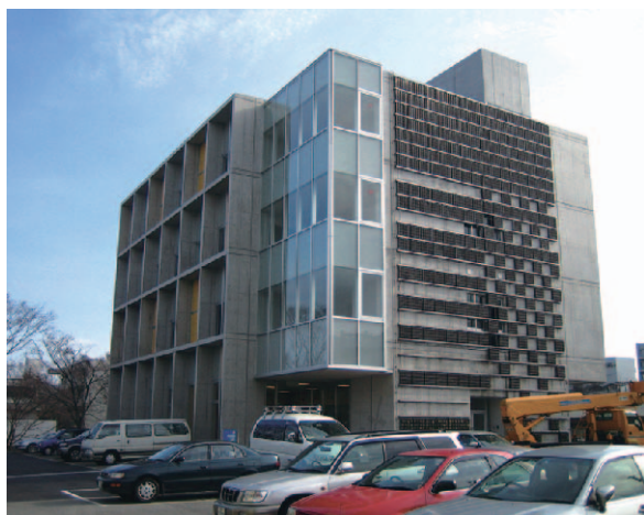
FRC研究棟 (2005.12 竣工) 大阪大学大学院工学研究科 フロンティア研究棟1号館
