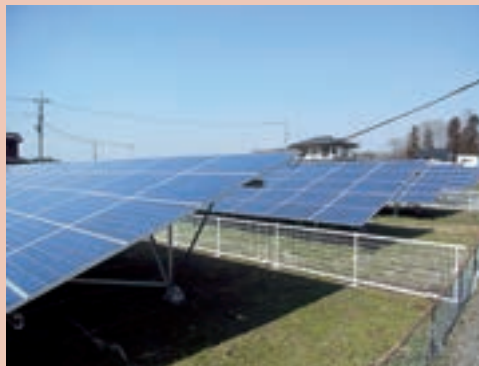
真岡工場に設置された太陽光発電システム
