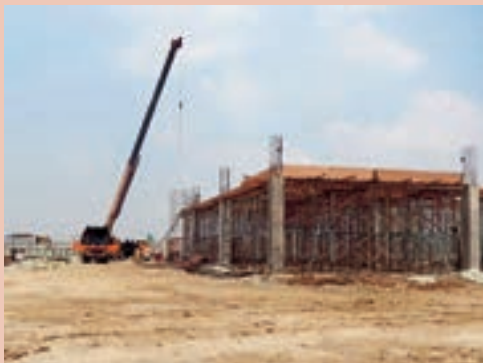
建設中のPT.DYNIC TEXTILE PRESTIGE
