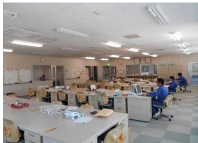
技術棟エアコン更新
