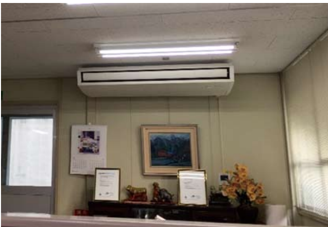
第三工場事務所
