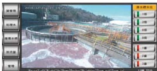
排水処理設備エリア監視画面
