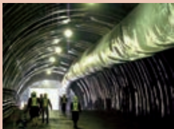
トンネル工事に使用された風管
