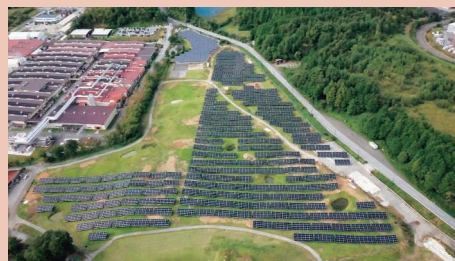
多賀グリーンクラブ太陽光発電システム
